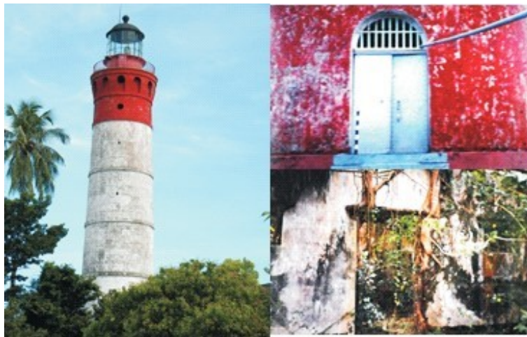
Gambar 5. Mercusuar Pulau Breuh dan reruntuhan bangunan di kompleks menara (dok. BPCB Banda Aceh, 2012)
