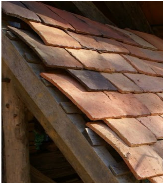
Gambar 8 : Susunan pemasangan atap genting Sumber :
