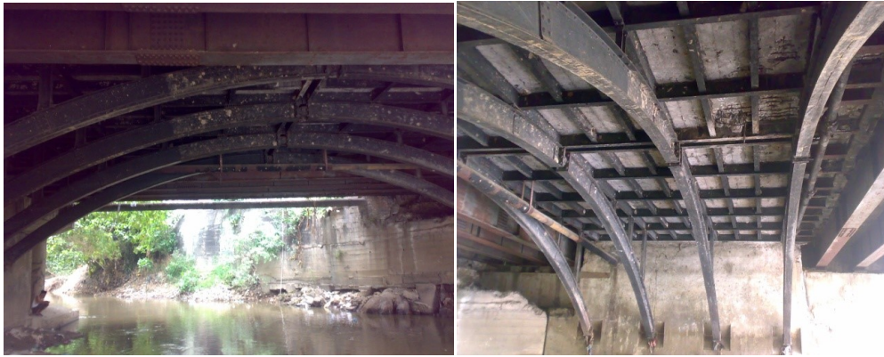
Konstruksi baja lengkung di bagian bawah jembatan (dok. Deni Sutrisna 2011)
