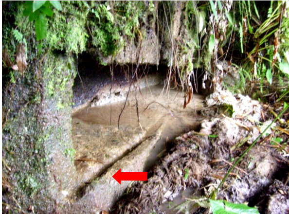
Gambar 1. Jalur rel untuk menggeser daun pintu (panah merah) (Dok. BP3 Banda Aceh, 2008)
